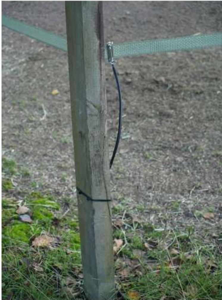
**Zapojení vysokonapětového kabelu vedoucího pod branou**
